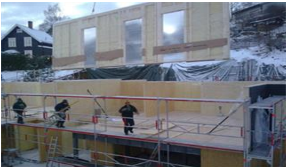
7 pav. Montavimo darbai statybvietėje
