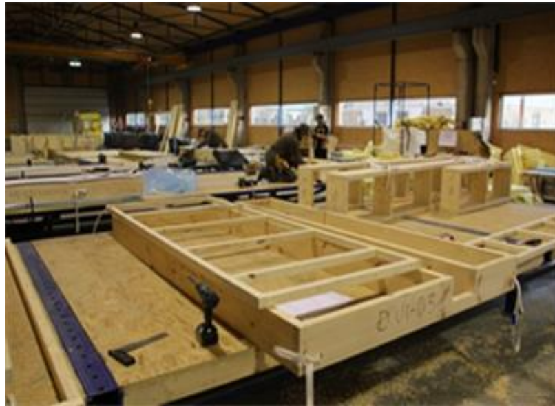
2 pav. Karkaso montavimas
