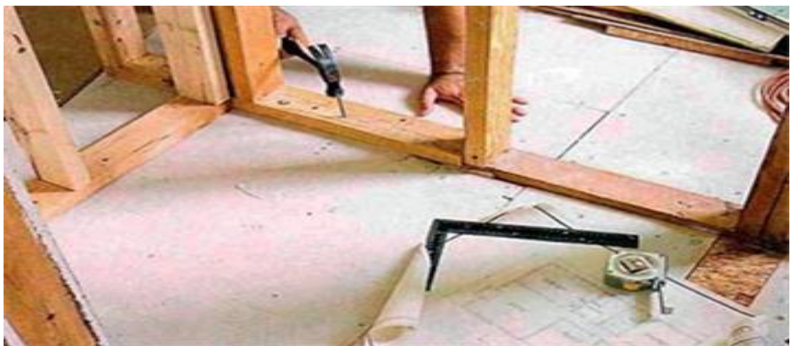
6 pav. Karkaso surinkimas
